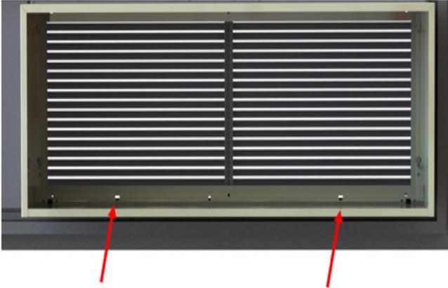
Revisa y asegúrate que todos los agujeros extras (y los tubos de drenaje interiores en caso de haber) estén abiertos y despejados de sellante alrededor la cara inferior externa de la manga PTAC. Permite un tiempo para que el sellante se seque en el perímetro antes de instalar la unidad PTAC. Continúa con la instalación de la unidad PTAC de acuerdo a las recomendaciones del fabricante.
